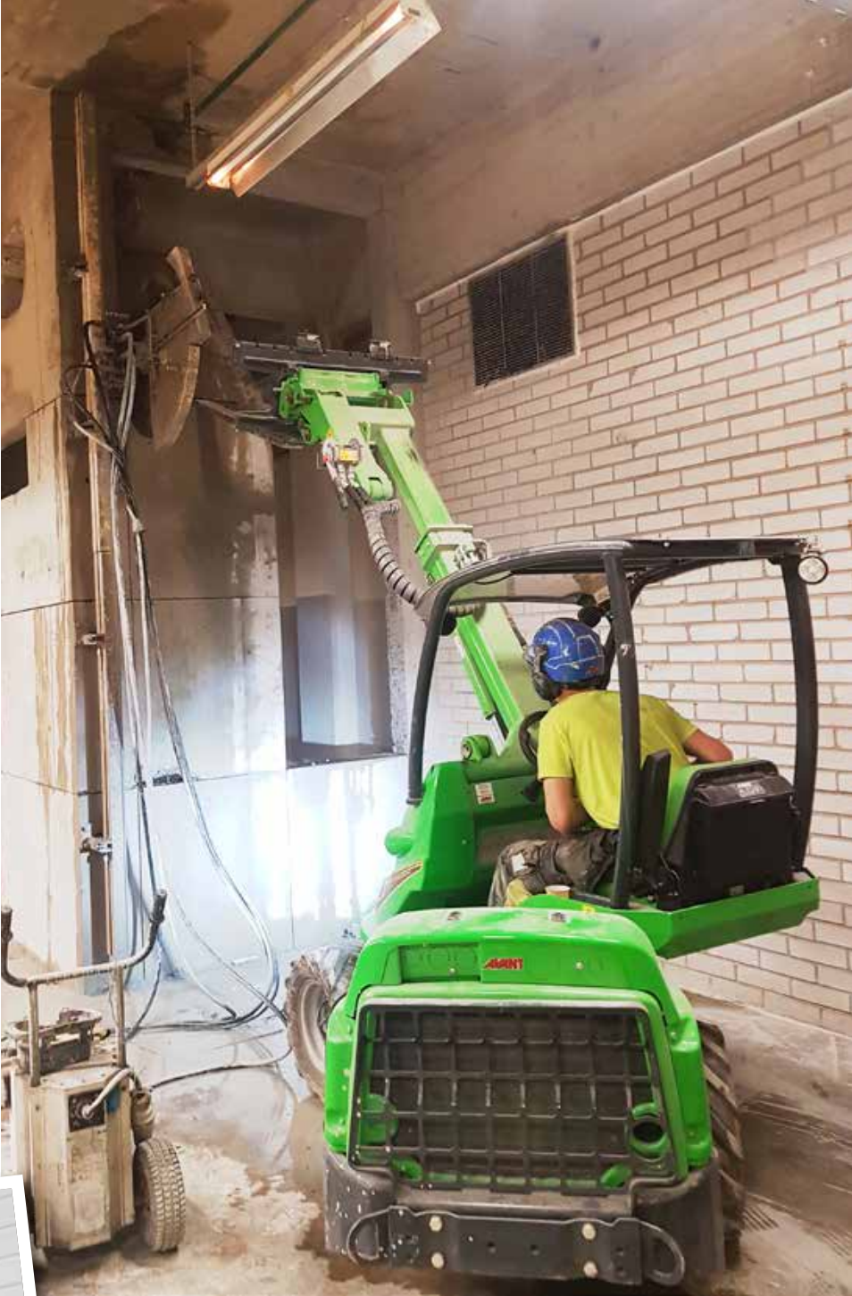
Kuvat: Tampereen Porausteam
